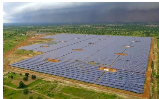
Le champ de panneaux solaires de la centrale photovoltaïque de Zagtoui, à proximité de Ouagadougou. Crédit photo : SONABEL.
